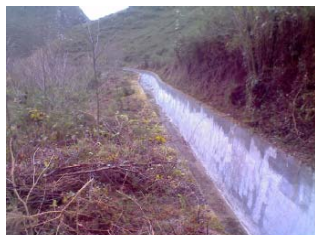
Desbroce finalizado de los márgenes del canal.
