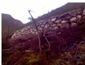
Aspecto de zona reforzada con escollera.
