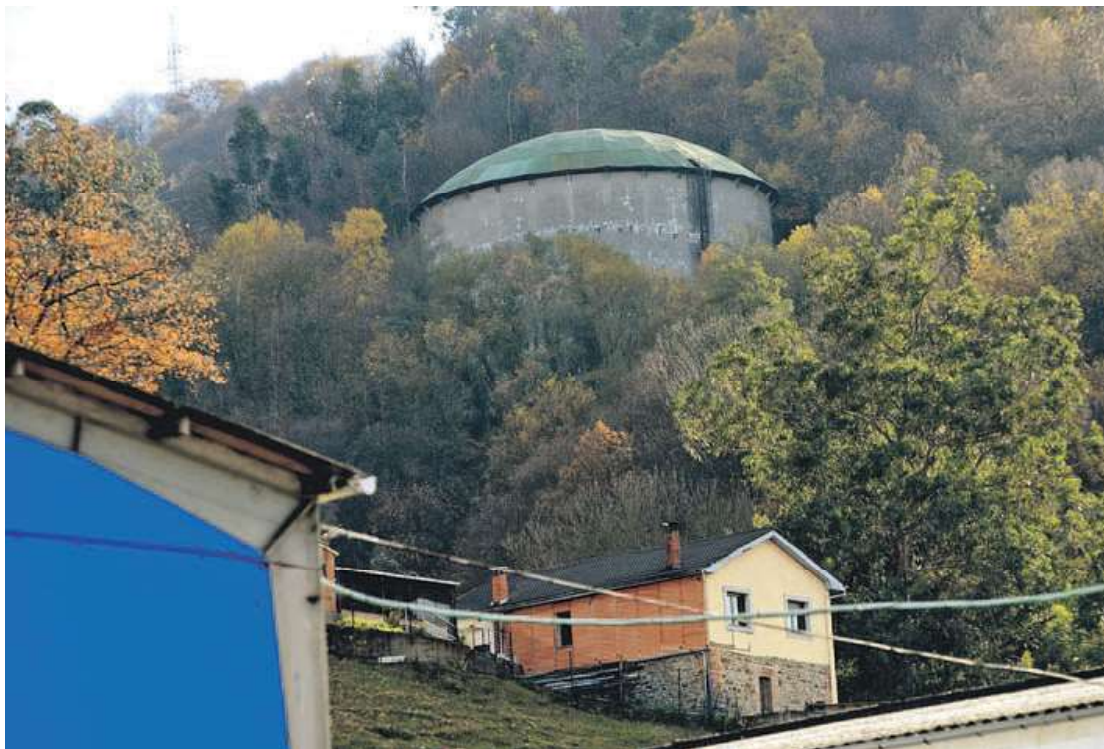
Instalaciones del depósito de La Herradura, en el que se va a instalar una planta hidráulica de carácter experimental. | J. R. SILVEIRA
